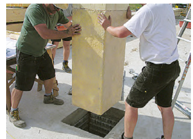
Abb. 6.3 Einbau einer unmittelbar in Stahlbetonfundamente eingespannten BS-Holz-Stütze
